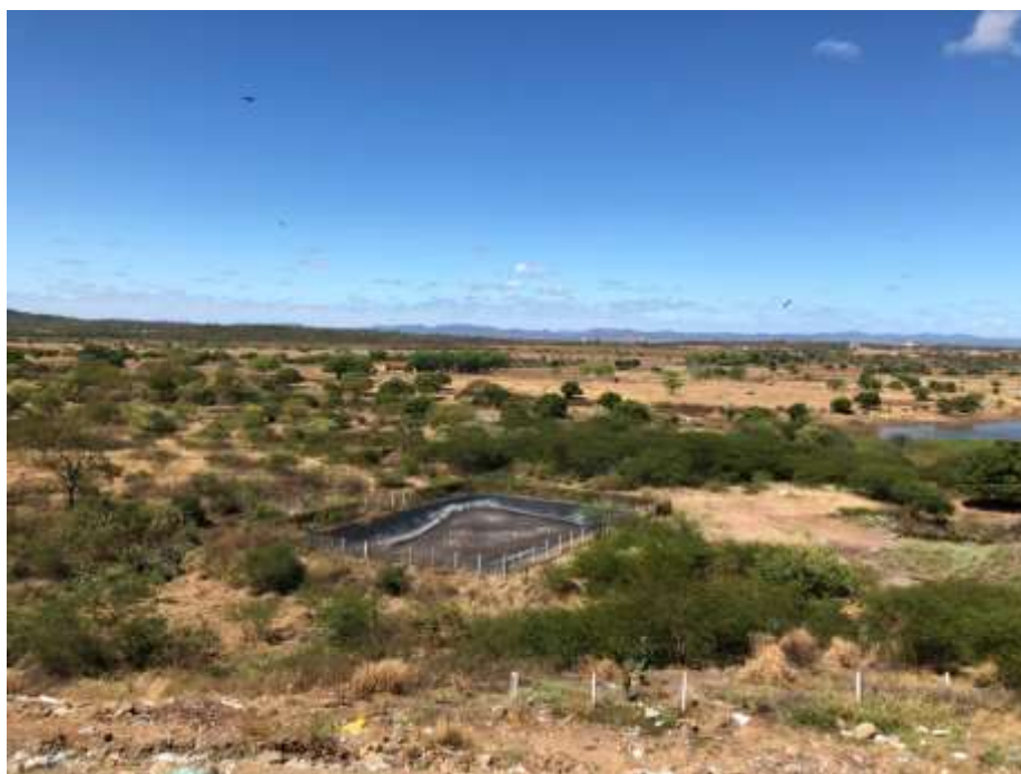
FIGURA 06: Tanque de captação de chorume.
