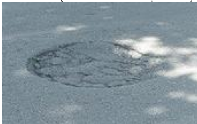
FIGURA 10: Poço de visita coberto com pavimentação.
